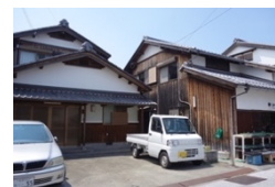
写真2 後退した建築物
