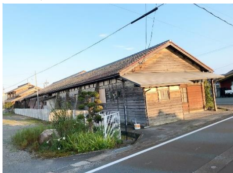
図2 かつての作業場とされる建築物木造の斜材が飛び出している(撮影は筆者による)
